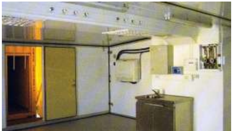
شکل ۲۰-۲ سقف کاذب جهت گذر لوله‌های گاز در اتاق عمل در بیمارستان سیار
